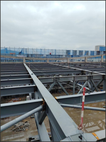
钢结构安装生命线
