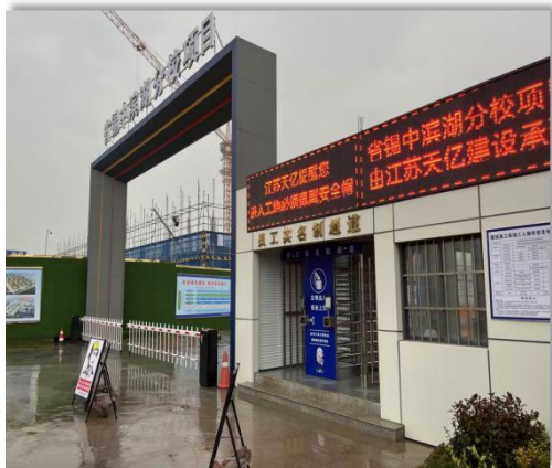
施工现场大门
