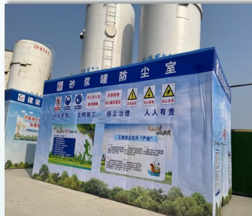
成品砂浆集中搅拌区
