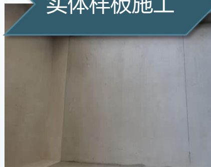
实体样板施工
