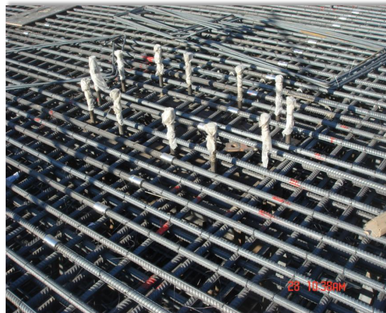
钢骨柱地脚螺栓成品保护
