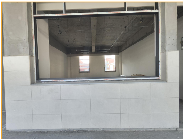
标准班教室走道墙砖铺贴
