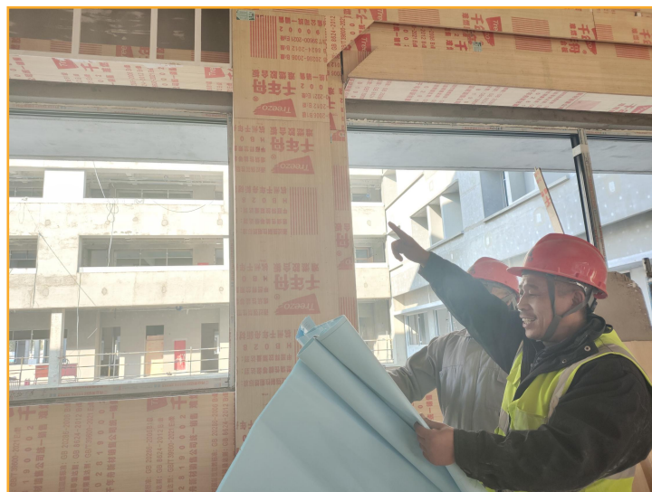
班组施工现场交底
