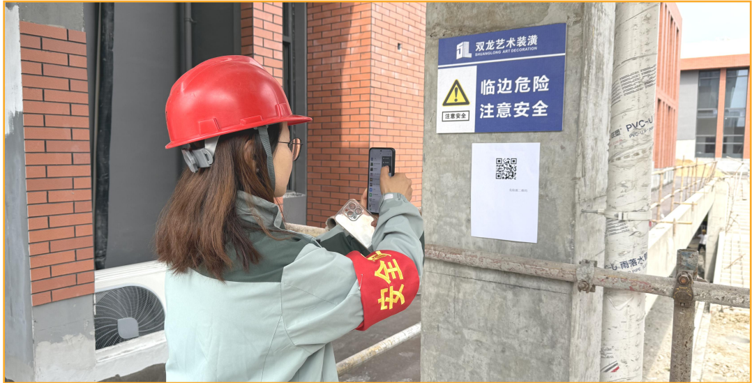
专职安全员每日巡检扫码
