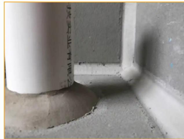
管根及墙角圆弧处理
