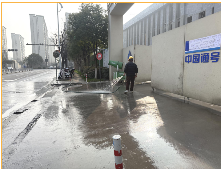
车辆出入通道冲洗除尘
