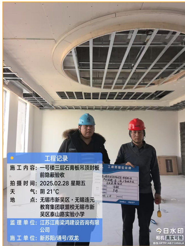
1#3层吊顶封闭前隐蔽验收
