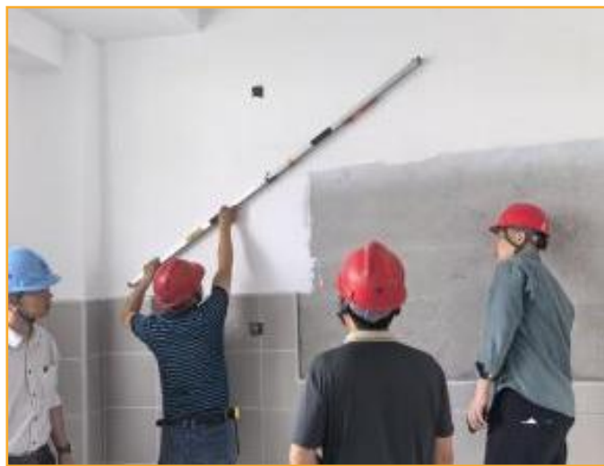
墙面涂料工序交接验收
