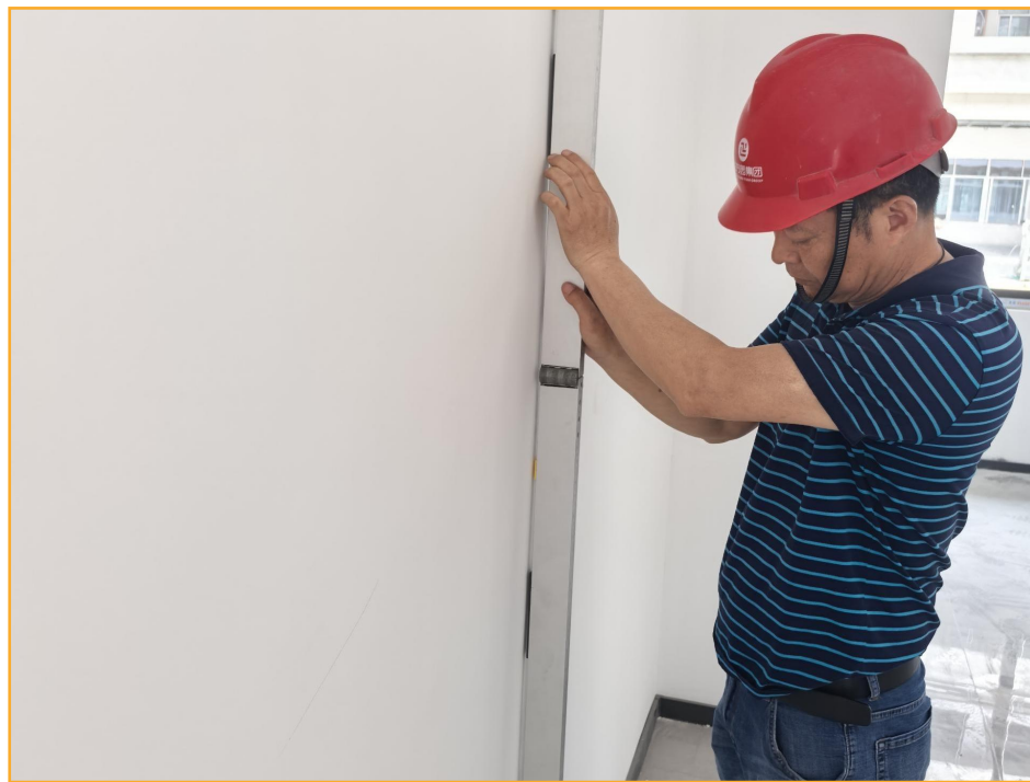
墙面涂料喷涂前平整度检查
