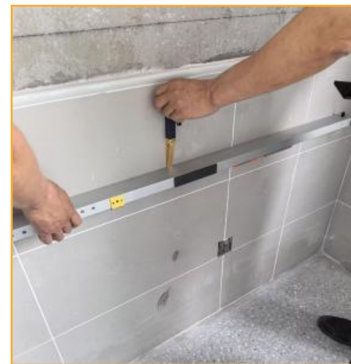
墙砖平整度专检
