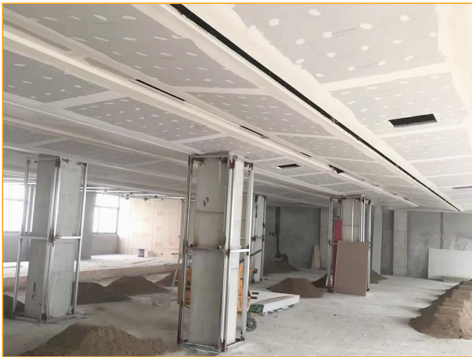
防锈漆涂抹钉眼、嵌缝石膏、网格布多种措施防止开裂
