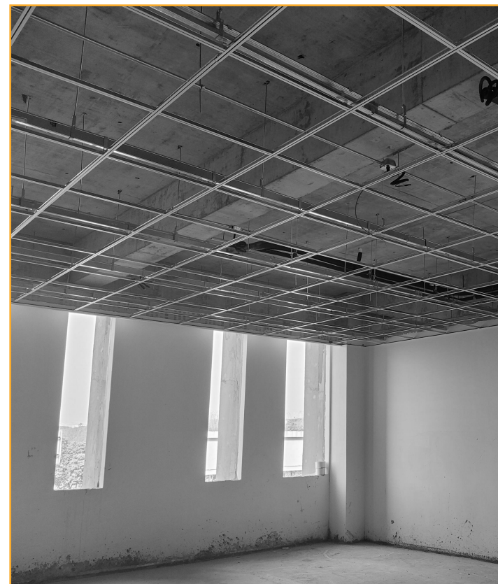
硅酸钙板吊顶龙骨牢固均匀顺直
