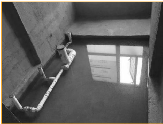
卫生间48H蓄水试验
