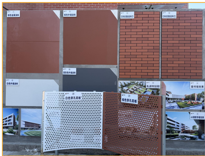
涂料、穿孔铝板工艺样板
