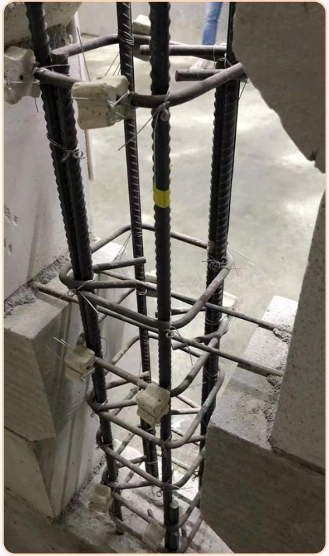
铝板吊顶样板/构造柱、钢筋样板
