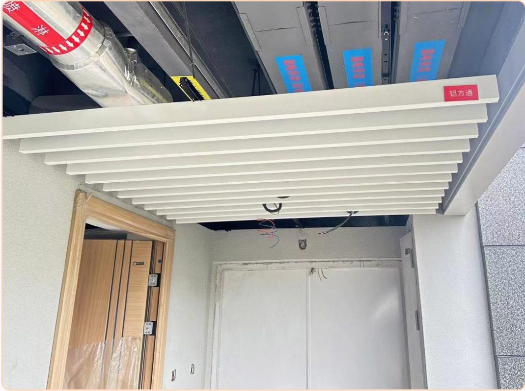
吊顶样板展示
