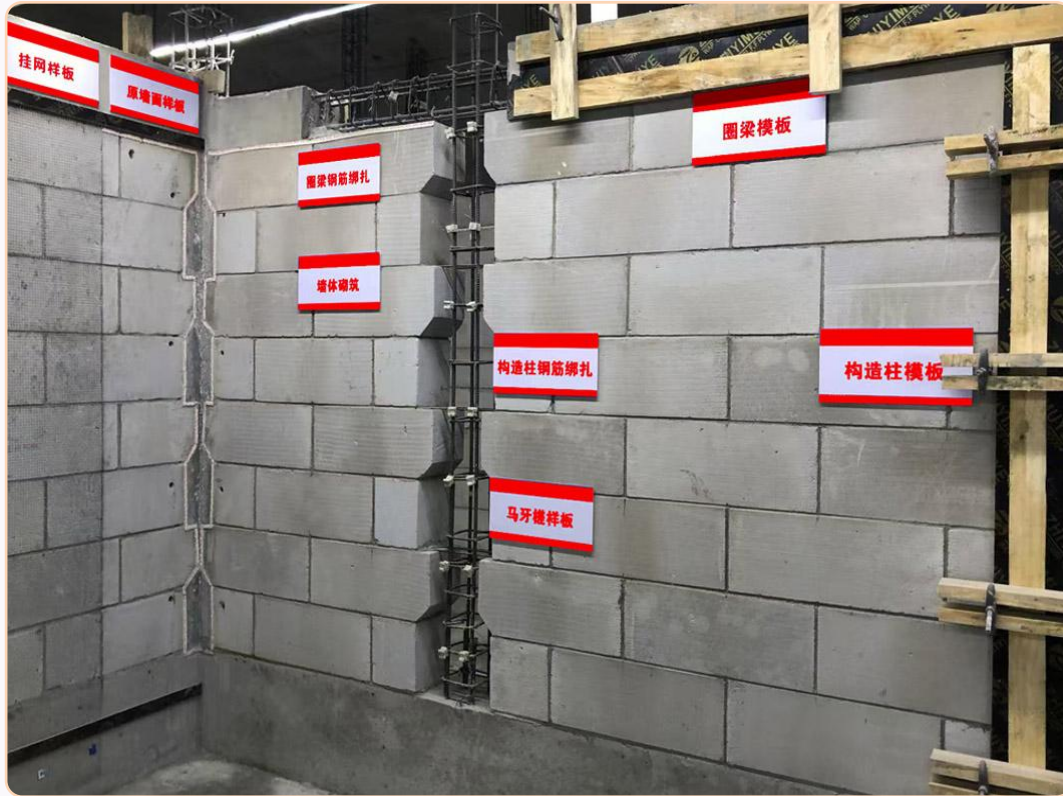
二次砌筑样板
