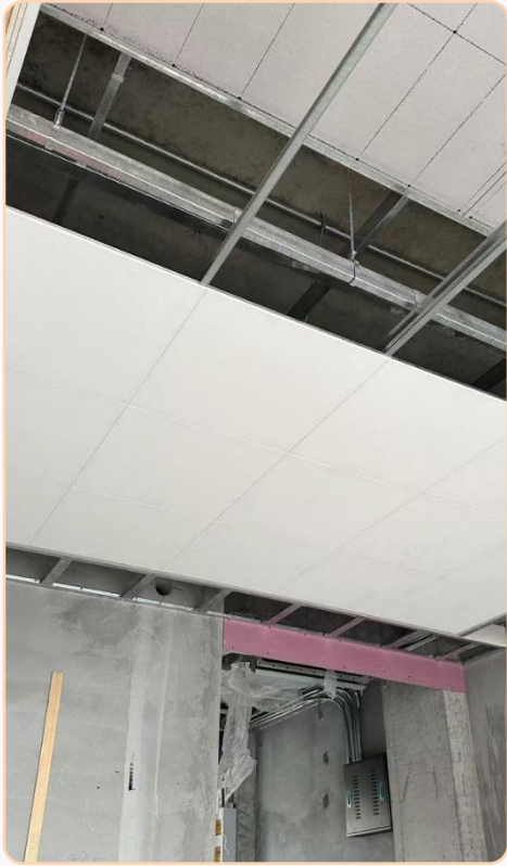
铝板吊顶样板/构造柱、钢筋样板
