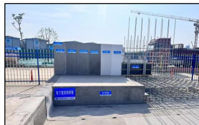
地下室主体结构样板
