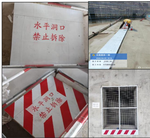
水平洞口、竖向洞口临边防护
