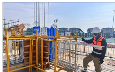
梁柱节点样板
