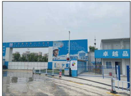
扬尘监测系统
