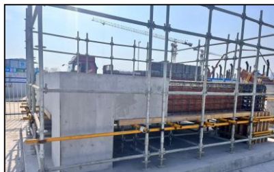
地上主体结构样板
