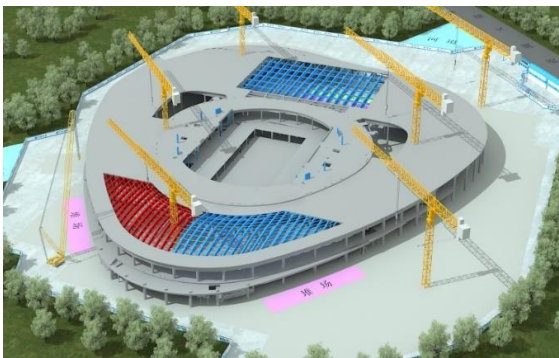
钢结构吊装模拟
