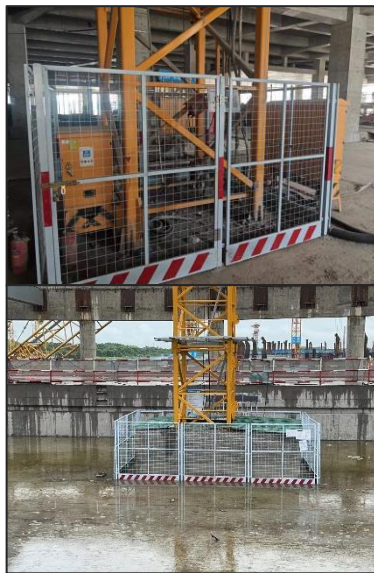
塔吊洞口防护
