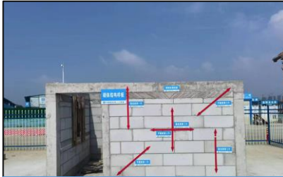
砌体二结构样板
