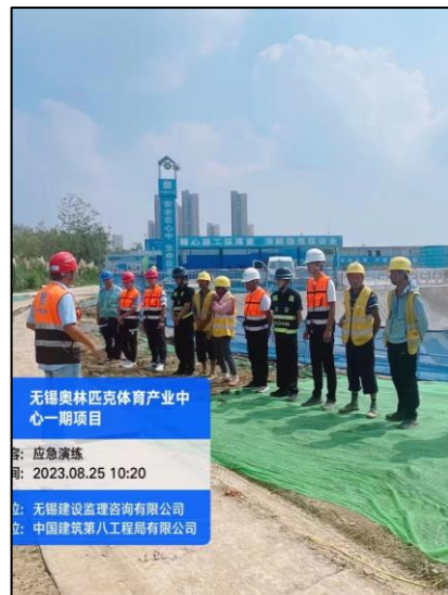
基坑坍塌应急演练
