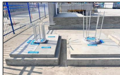
桩头防水样板
