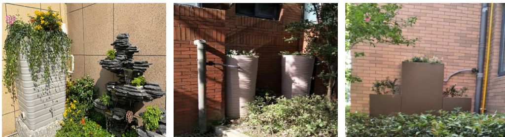
图 5.3-1 雨水罐实景图
