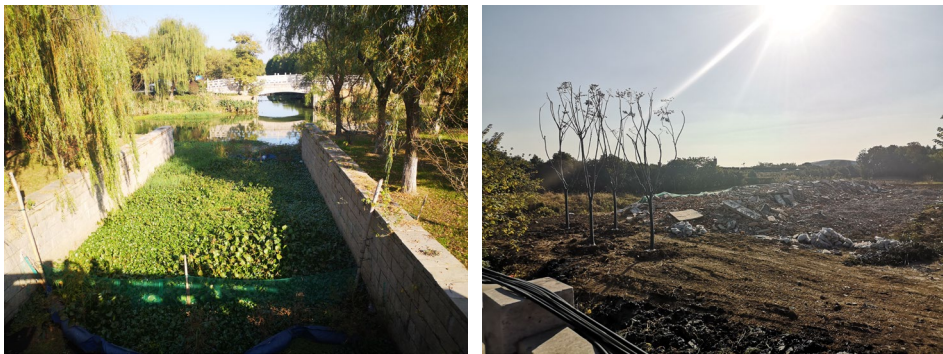
图 6.6-4 改造前河道水质较差、建筑垃圾堆积
