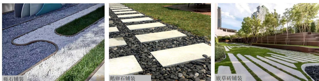
图 5.2-1 透水铺装实景图
