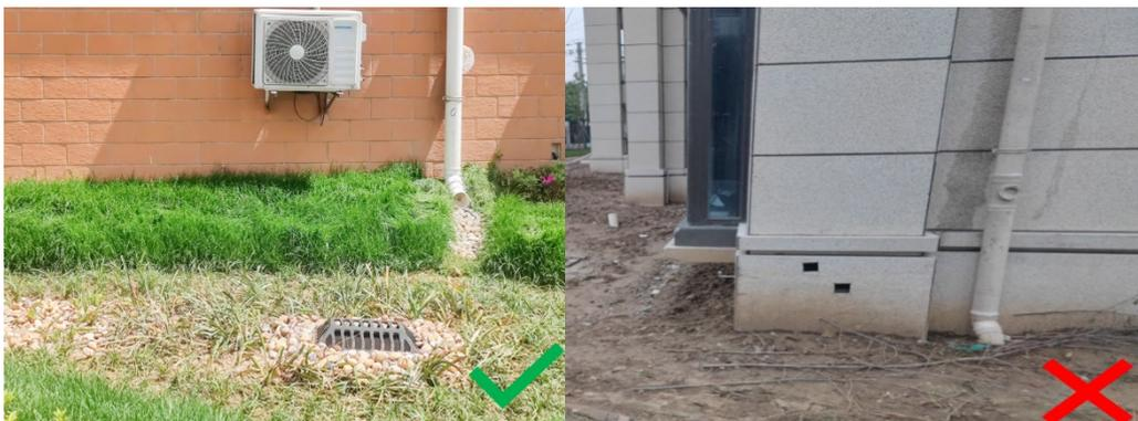
图5.16-1 雨水断接施工对错对比图
