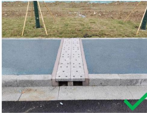
图5.14-2 过水暗涵正确施工示范
