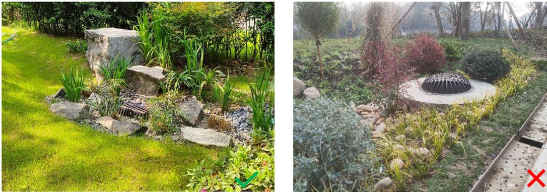
图5.3-3 溢流井施工对错对比图
