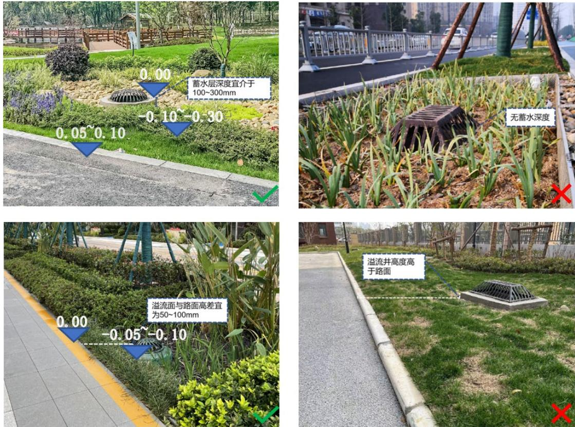
图5.3-2 生物滞留设施施工对错对比图
