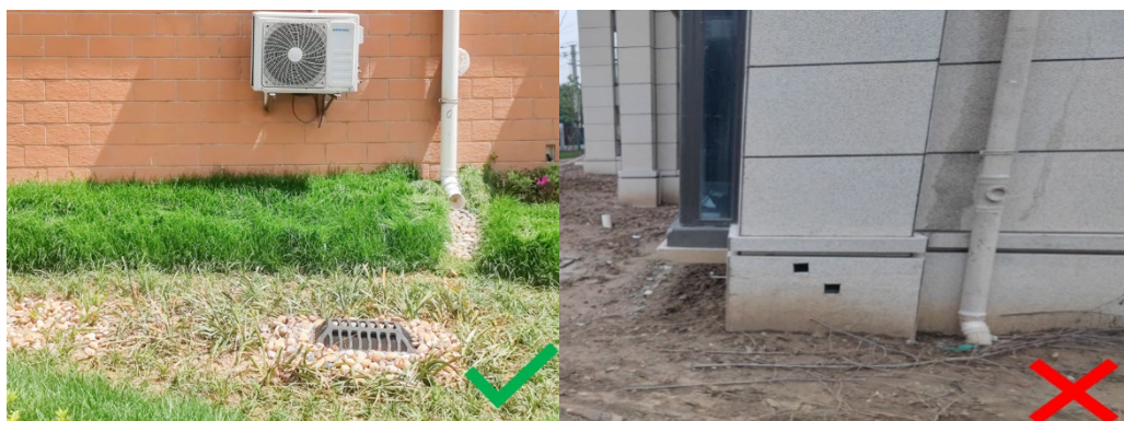
图5.16-1 雨水断接施工对错对比图
