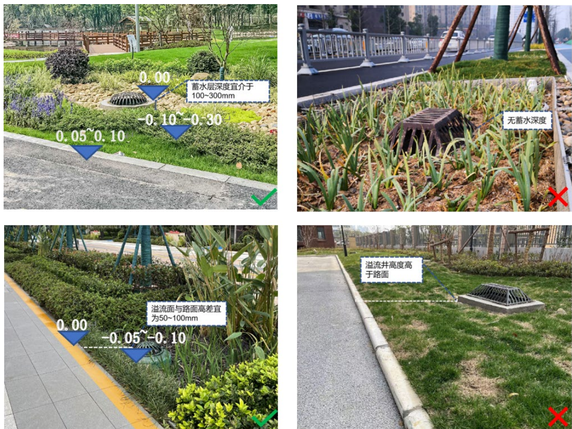
图5.3-2 生物滞留设施施工对错对比图
