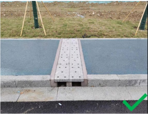
图5.14-2 过水暗涵正确施工示范
