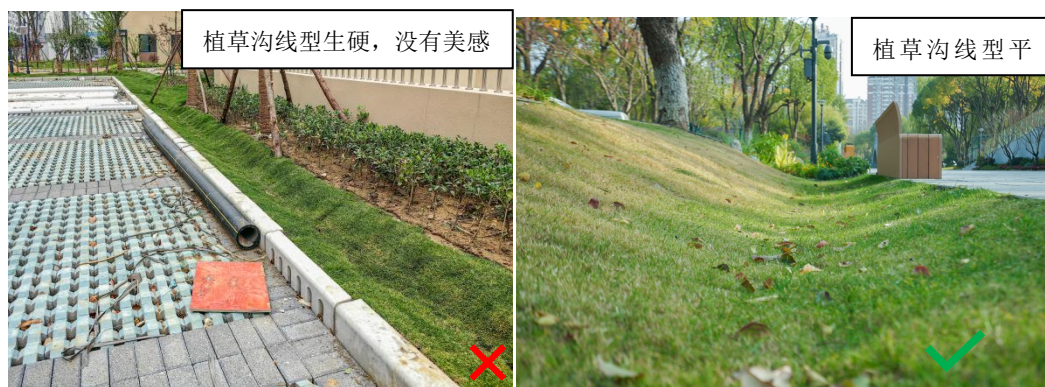
图5.13-2 植草沟施工对错对比图
