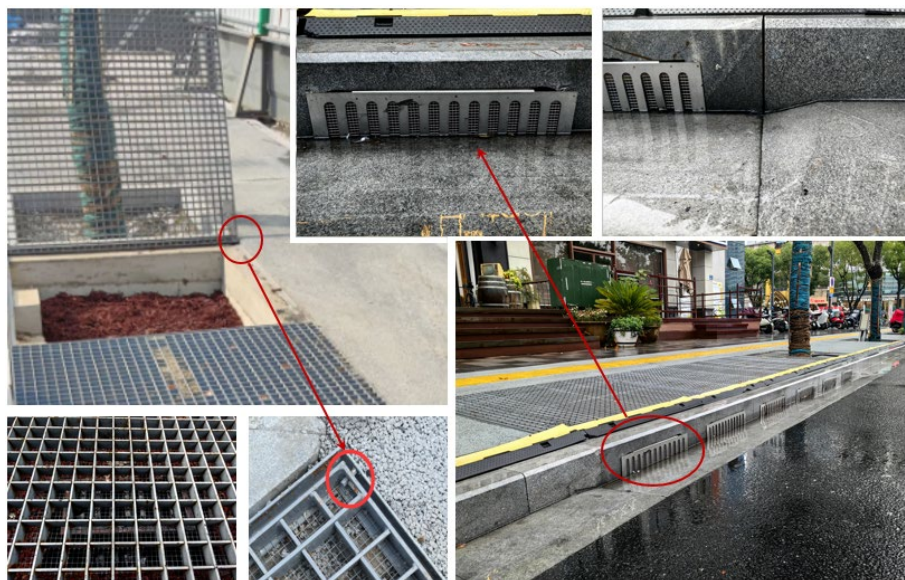
图 6.4-14 生物滞留带细部处理
