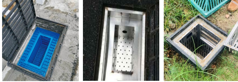
图5.2-22溢流口截污设施实景图
