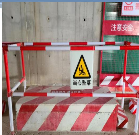
楼面洞口防护
