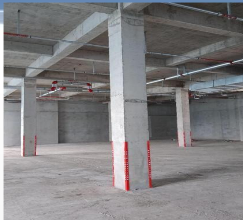
混凝土柱梁板
