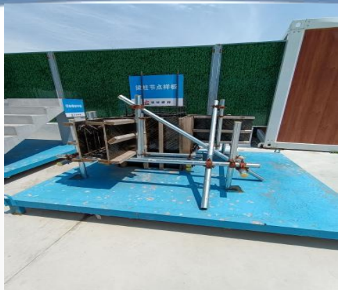
梁柱节点样板
