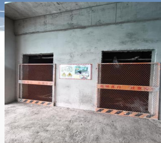
定型化电梯门洞围护
