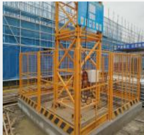
定型化塔吊围护
