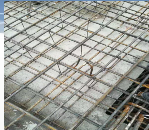
废旧钢筋制作马凳
