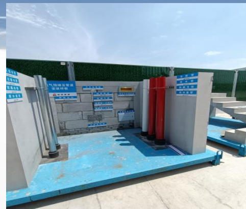
电气预埋及管道 安装样板
