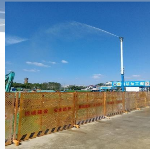
定型化基坑围护
