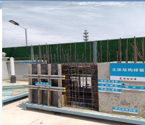
主体结构样板
