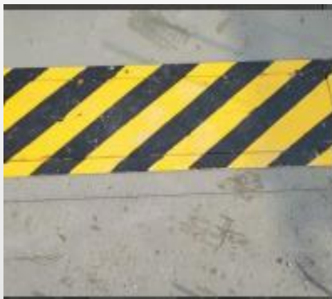
边角料模板用于 后浇带盖板
