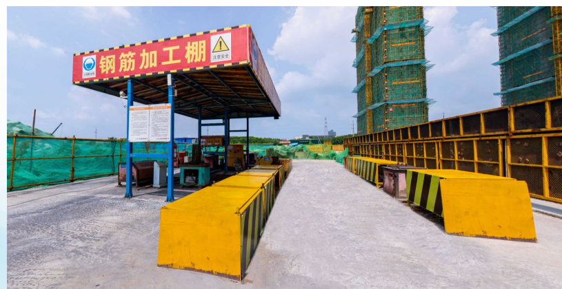
定型化钢筋防护棚
