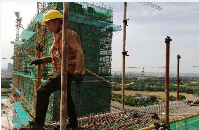
脚手架搭设使用生命线
