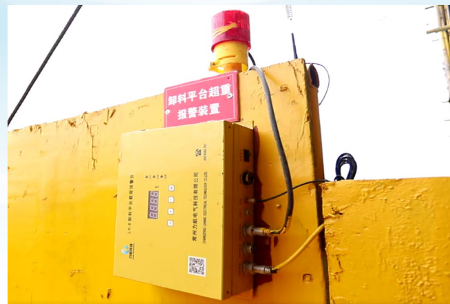
卸料平台限载监控
