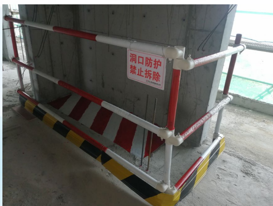
大型洞口防护
