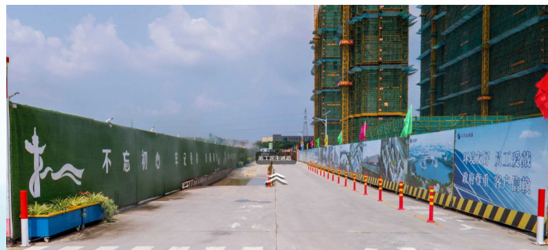
施工区人车分流主道路
