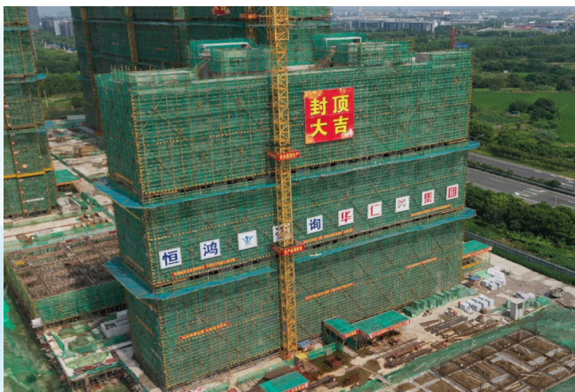
脚手架外立面
