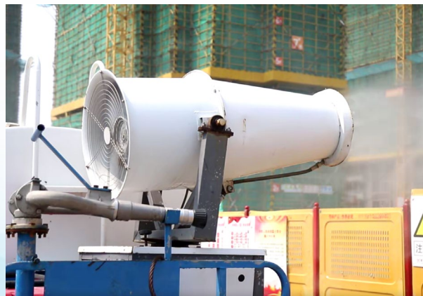
雾炮降尘作业
