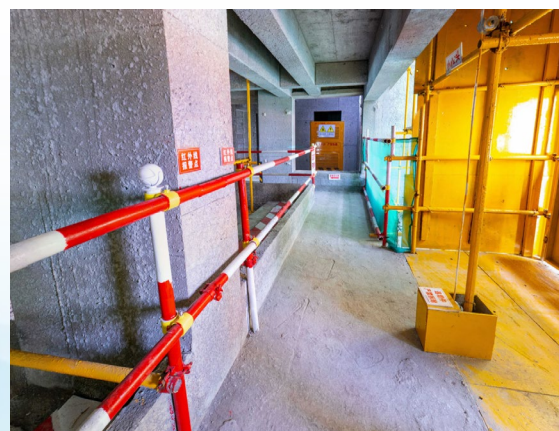
楼层临边防护
