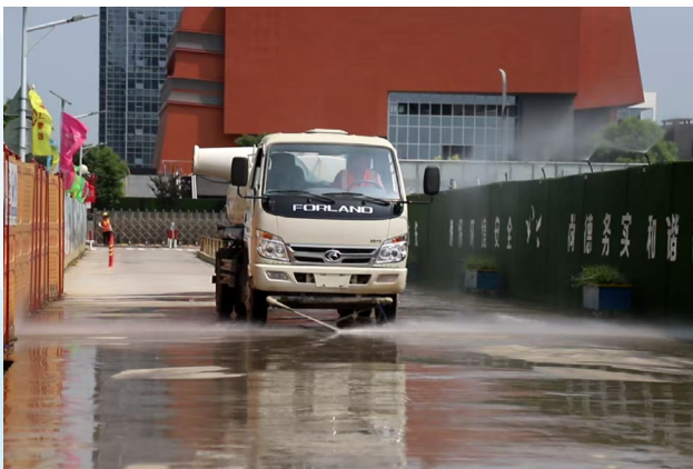
现场配置洒水车降尘
