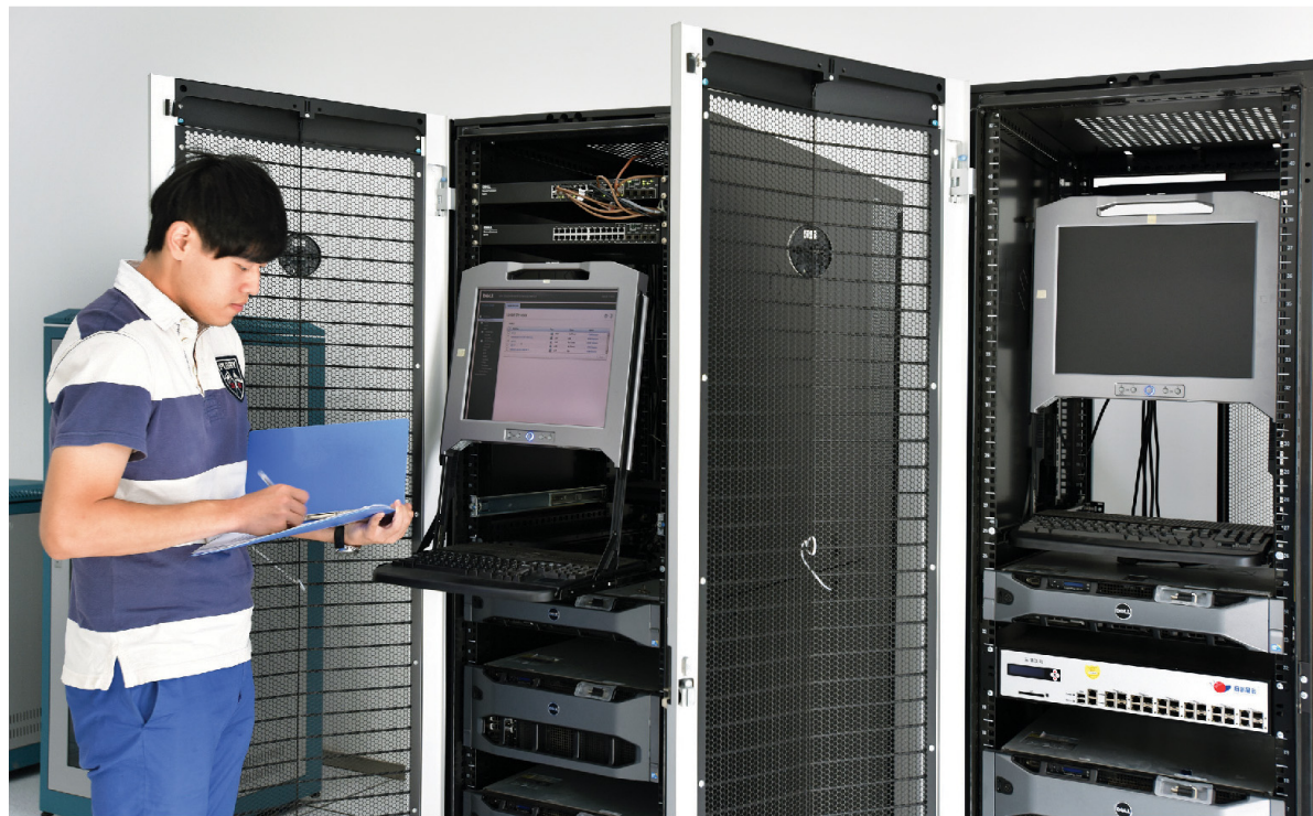
无锡市建筑能耗数据中心设备机房数据抄录
