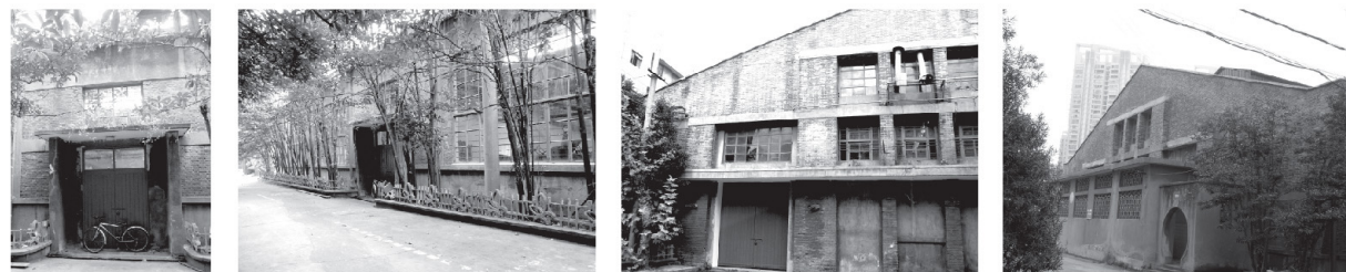
民族工商业档案馆改造前旧貌
